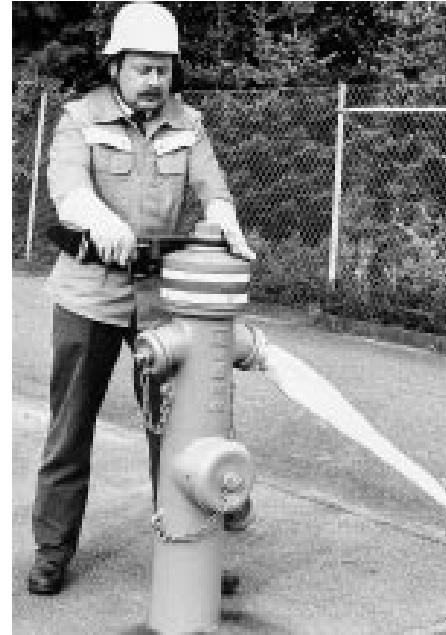
Überflurhydrant mit freiliegenden oberen Abgängen
